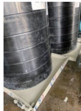
廢水處理廠的 PH 調整 加藥槽新增集液設施
